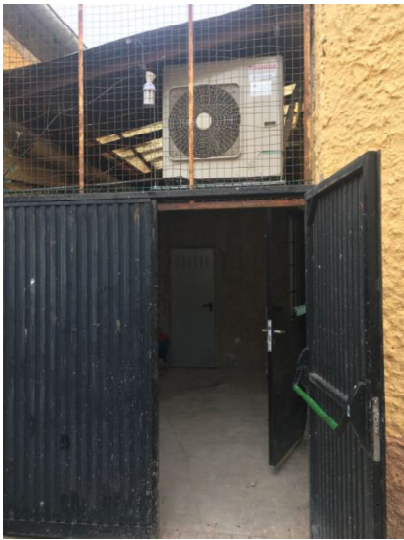
ACCESO SECUNDARIO_ESTADO ACTUAL
